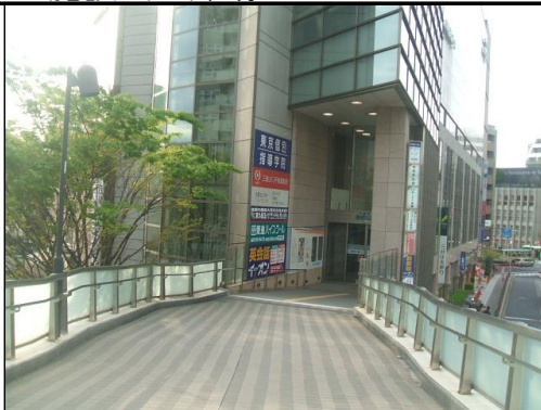
■施設入口外観
